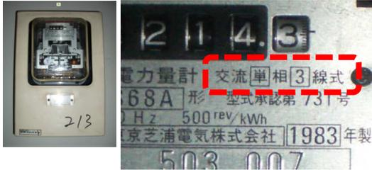
古いマンションの中には、電気の配電方式が「単相2線式」で最大電気容量が、30Aまでしか契約できないものもあります。電気容量が少ないと、各室のエアコンを同時に使用したり、炊飯時に電子レンジを使うとブレーカーが落ちてしまうなど生活に制限が出る場合があります。マンション全体の容量によっては、「単相3線式」にして契約アンペアを上げられる場合もあるので、管理会社に確認しましょう。
