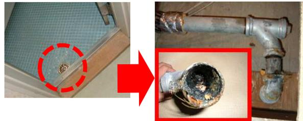
古いマンションの場合、排水管が閉塞・腐食していることも考えられ、その場合は高圧洗浄が必要となります。ただし、古いマンションは、腐食が進んで高圧洗浄が出来ない場合や構造上交換できない場合もありますので、配管ルート等も含めて、管理会社に確認しましょう。
