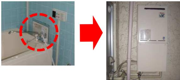
ガスの火力を使う給湯器は、できれば室外に設置したいものですが、マンションによっては外壁に穴があけられず、室外に設置できない場合もあります。その場合は、既存と同等の給湯器との交換になり、追焚きが出来なかったり容量が制限されることがあるので、注意が必要です。
